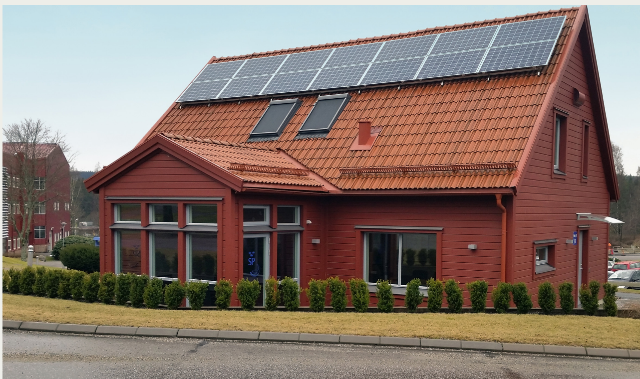
Figur 1. Forskningsvillan i Borås (foto: RISE).
